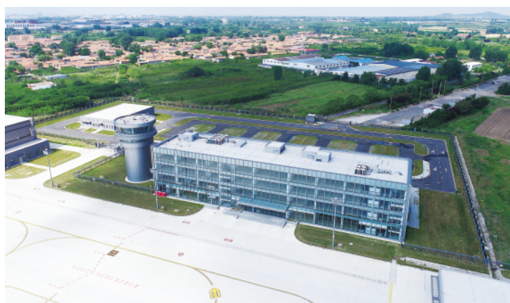
青岛即墨机场完成综合验收，正式开航。
